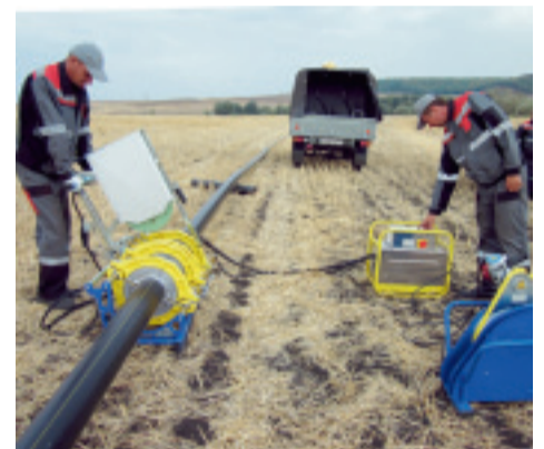
На строительстве межпоселкового газопровода с. Бахмут — хутор Янги-Аул.
