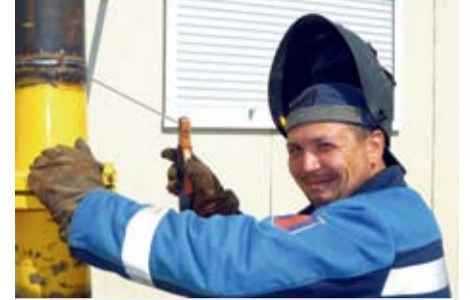
Электрогазосварщик-врезчик Виктор Иванов производит работы на газопроводе.
