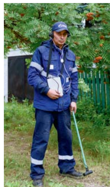
Монтер по ЗПТК Ренат Латыпов проводит приборное обследование газопровода.
