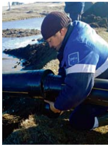
Монтажник наружных трубопроводов Айдар Атангулов – один из активных участников газификации Баймакского района.
