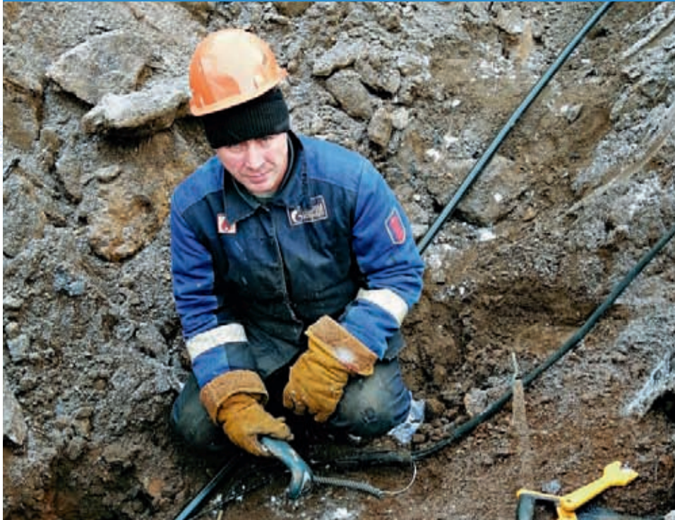
Электрогазосварщик Александр Базуев выполнил огромный объем работ.
