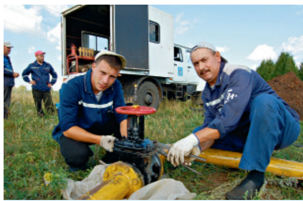
Булат Баширов и Геннадий Дементьев — на установке задвижки
