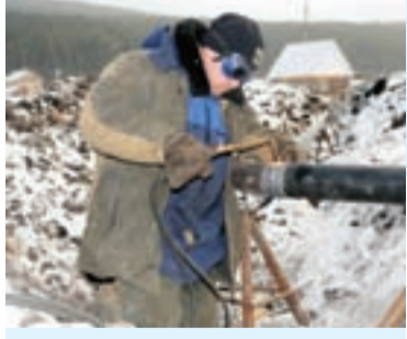
Сварщик А.В. Будув
