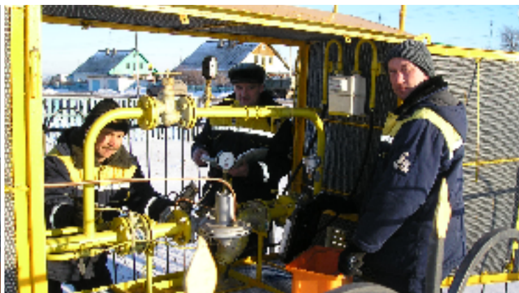
Слесари по эксплуатации и ремонту газового оборудования Сергей Карягин и Радик Ахияров на обслуживании ГРП
