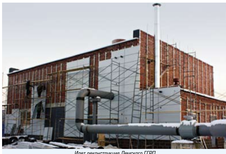
Идет реконструкция Демского ГРП
