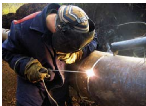
Перенос действующего газопровода осуществлен в короткие сроки
